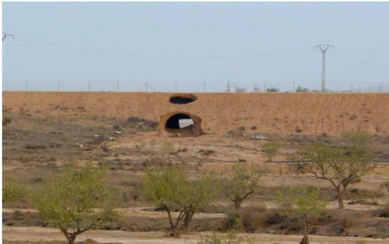
Fotografía 2.- Dique de contención de agua y solera de una balsa, ambas con patologías por la presencia de agua en el terreno
